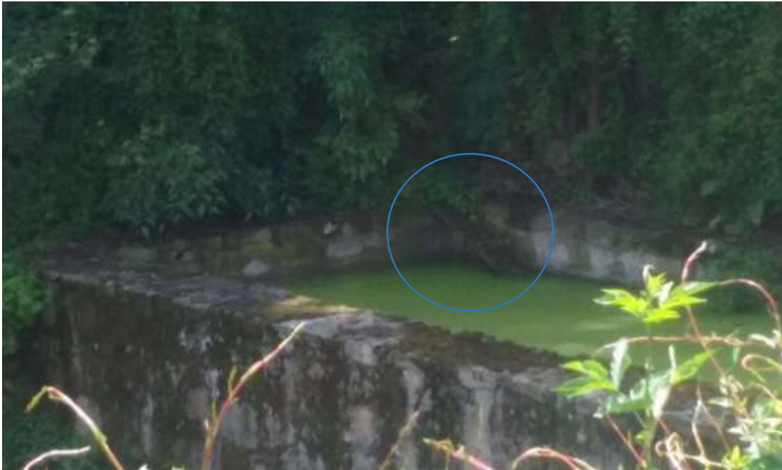
Rampa de salida de animales en un aljibe de riego.
