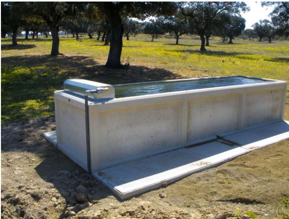
Abrevadero prefabricado de hormigón, sin salidas ni entradas de fauna.
