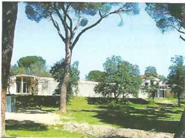
Vista exterior del nuevo hospital de fauna de Grefa, entre los pinos del Monte del Pilar, en Majadahonda (Madrid). Foto: Grefa.
