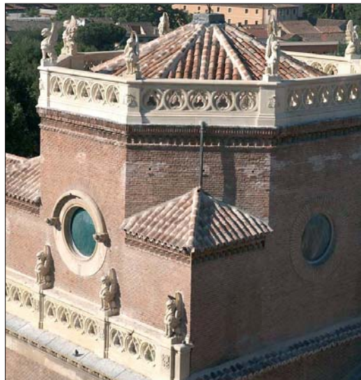
Tanto en la cruz como en los muros de la torre principal de la Iglesia del Convento de las Bernardas se realizaron adaptaciones de los mechinales para favorecer la reproducción del cernícalo primilla
