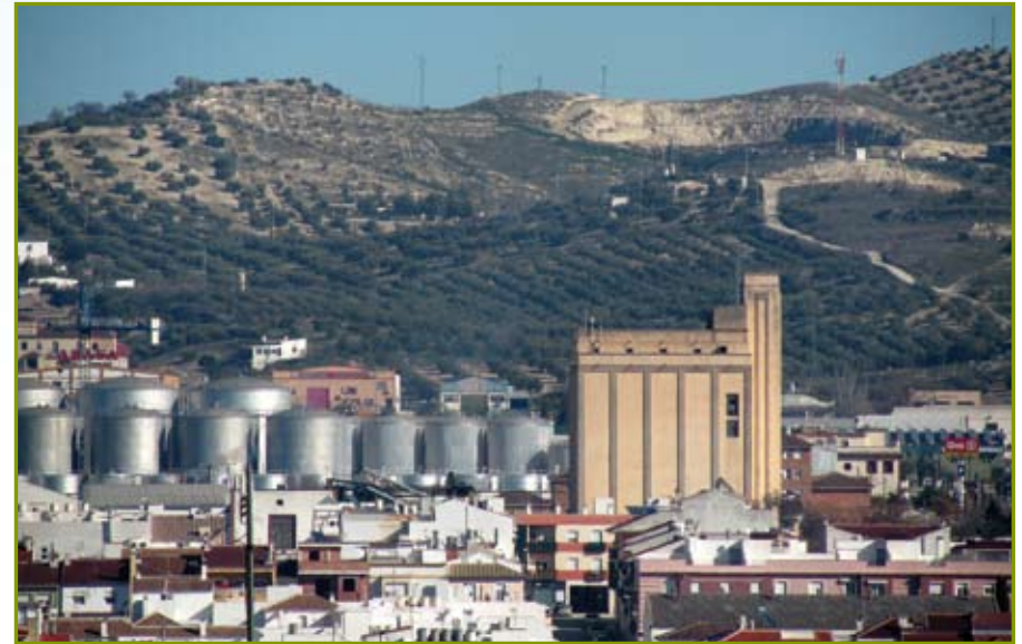
Uno de los silos donde se han realizado las actuaciones.
