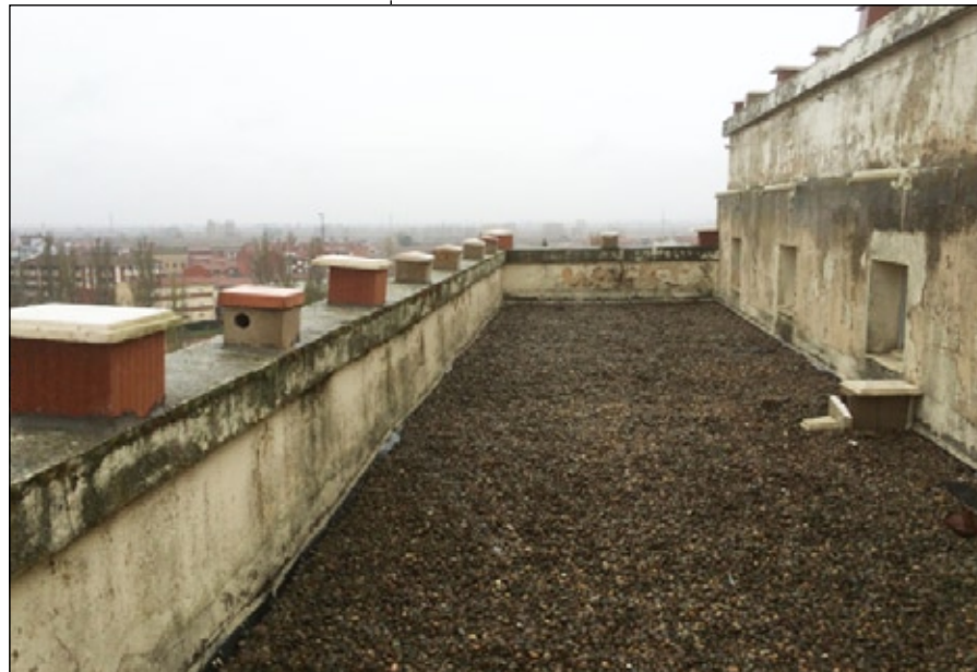
Batería de nidas instalados en la azotea del silo de Santa María del Páramo (León).
