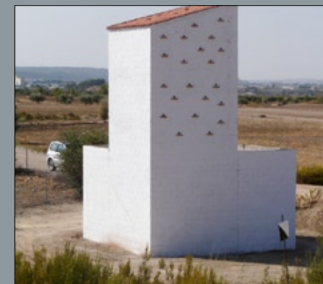
Aspecto del primillar recién construido en Arganda del Rey (Madrid).
