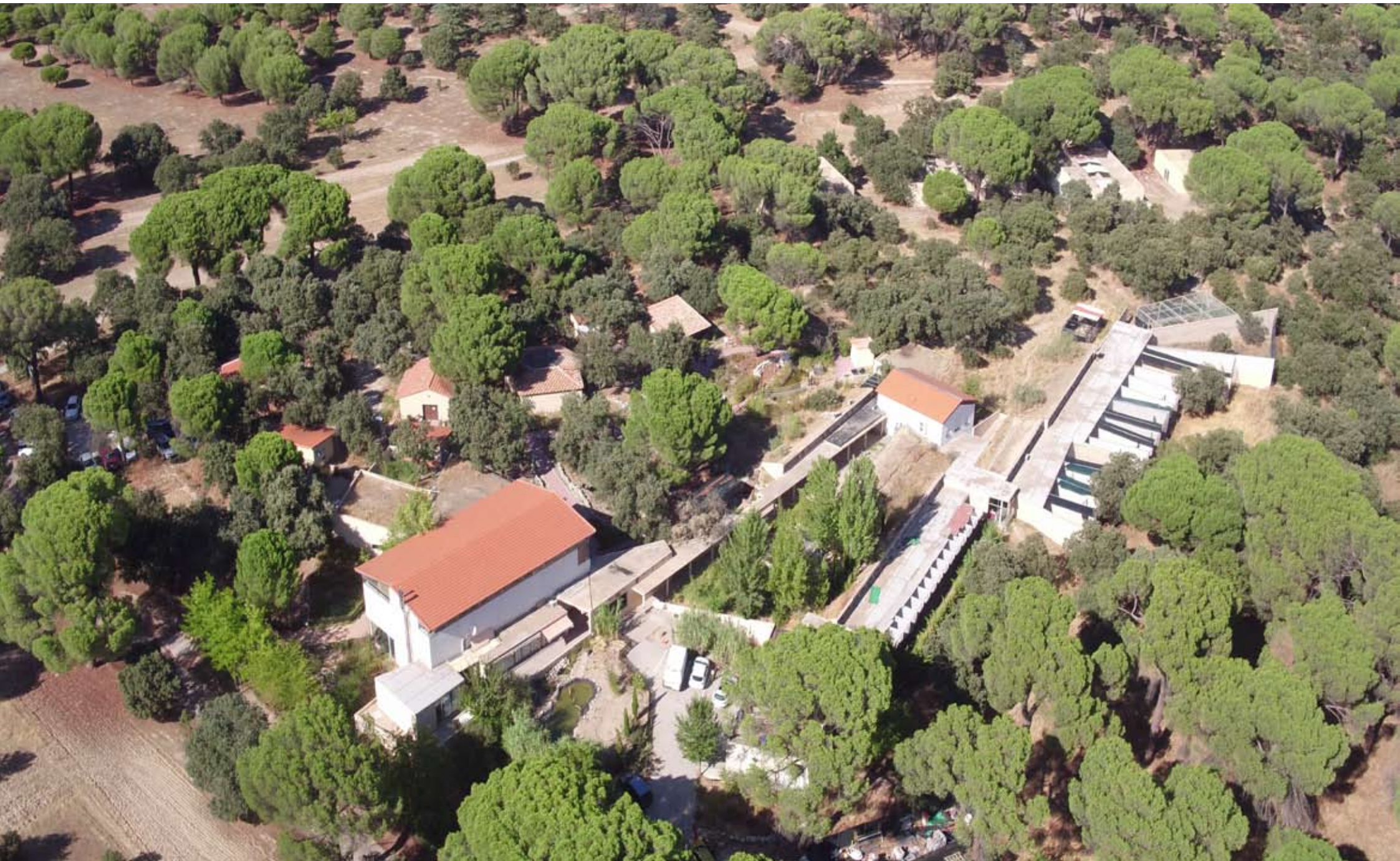
Vista aérea del Hospital de Fauna Salvaje de GREFA, en Majadahonda (Madrid), y otras dependencias de este centro. Foto: Kelsing.
