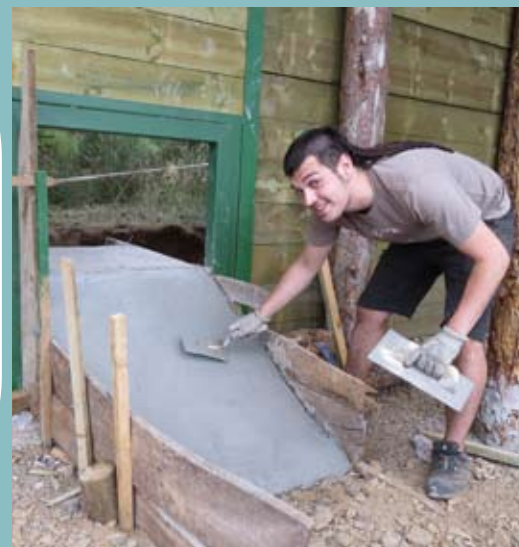
Un voluntario ayuda a construir un jaulón de aclimatación para el proyecto de recuperación del buitre negro en la sierra de la Demanda.
