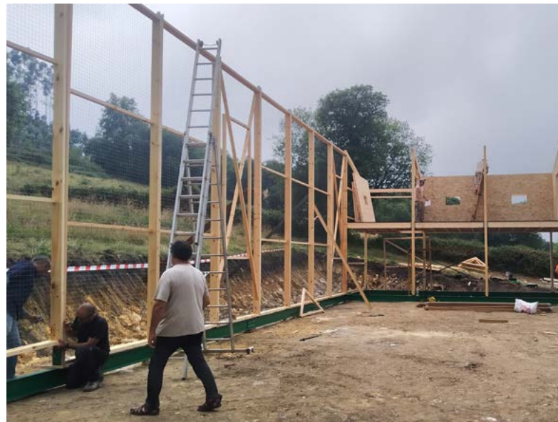
Construcción de la jaula
