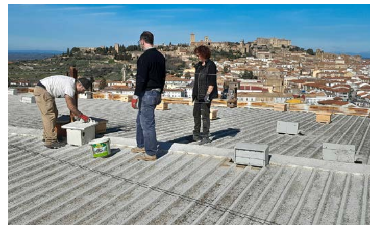
Equipo de trabajo adecuando nidos en uno de los silos de Trujillo para la temporada de cría de 2025. – Autor: Miguel.
