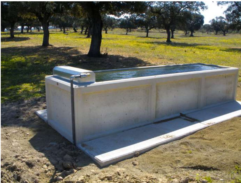
Abrevadero prefabricado de hormigón, sin salidas ni entradas de fauna.
