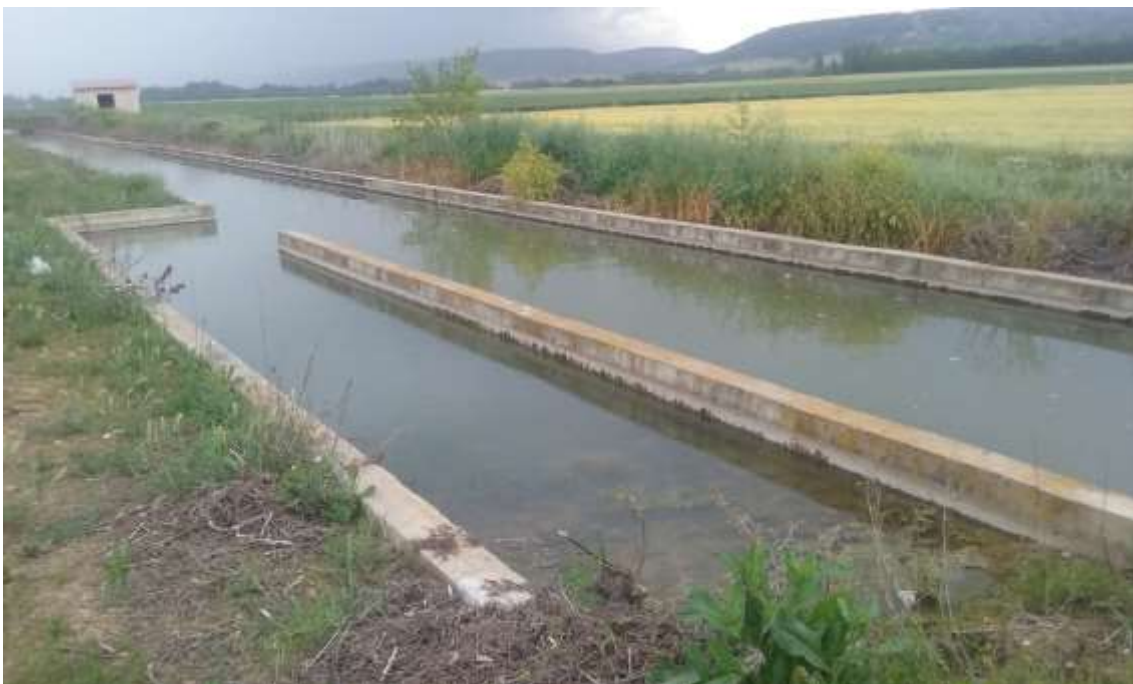
Otro ejemplo de salidero sin comunicación en el lado opuesto.
