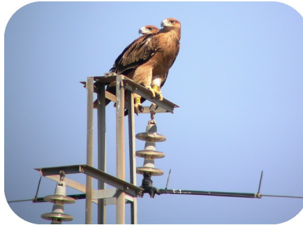
Águilas imperiales posadas en un apoyo corregido y ahora seguro para la avifauna
