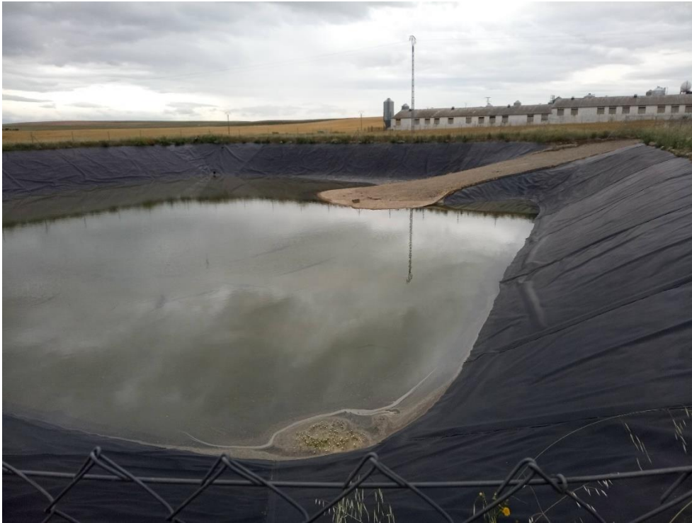
Balsa con rampa de acceso de hormigón con grandes dimensiones e inclinación suavizada.
