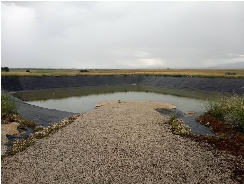
Ejemplo de rampa de hormigón con pendiente suavizada y superficie rugosa rastrillada.
