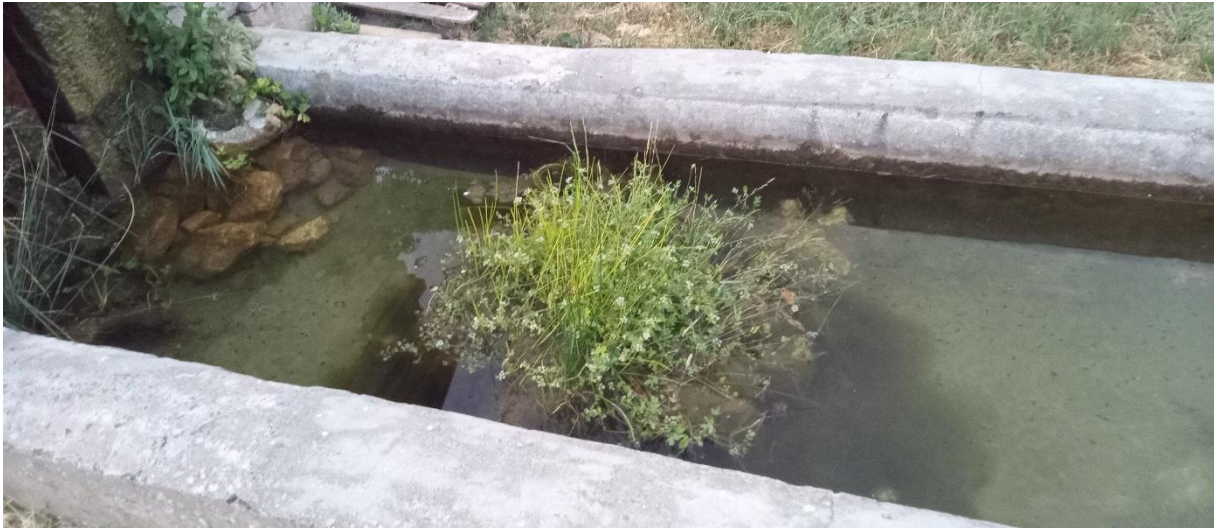
Ejemplo de isla flotante en un pilón de abastecimiento ganadero con paredes verticales de hormigón, donde se detectó proliferación de mosquitos y ahogamiento de fauna previamente a la intervención.
