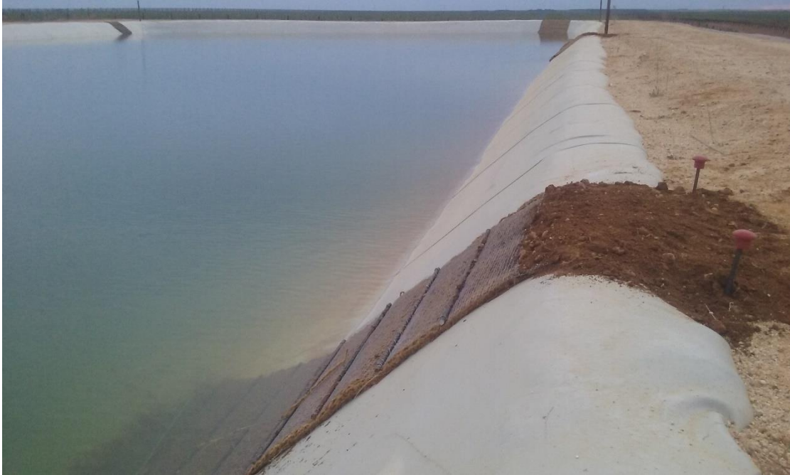
Rampas de salida en balsa de geomembranas vistas, instaladas por GREFA. Véase la disposición de dos rampas en los lados largos y una rampa en cada lado corto.
