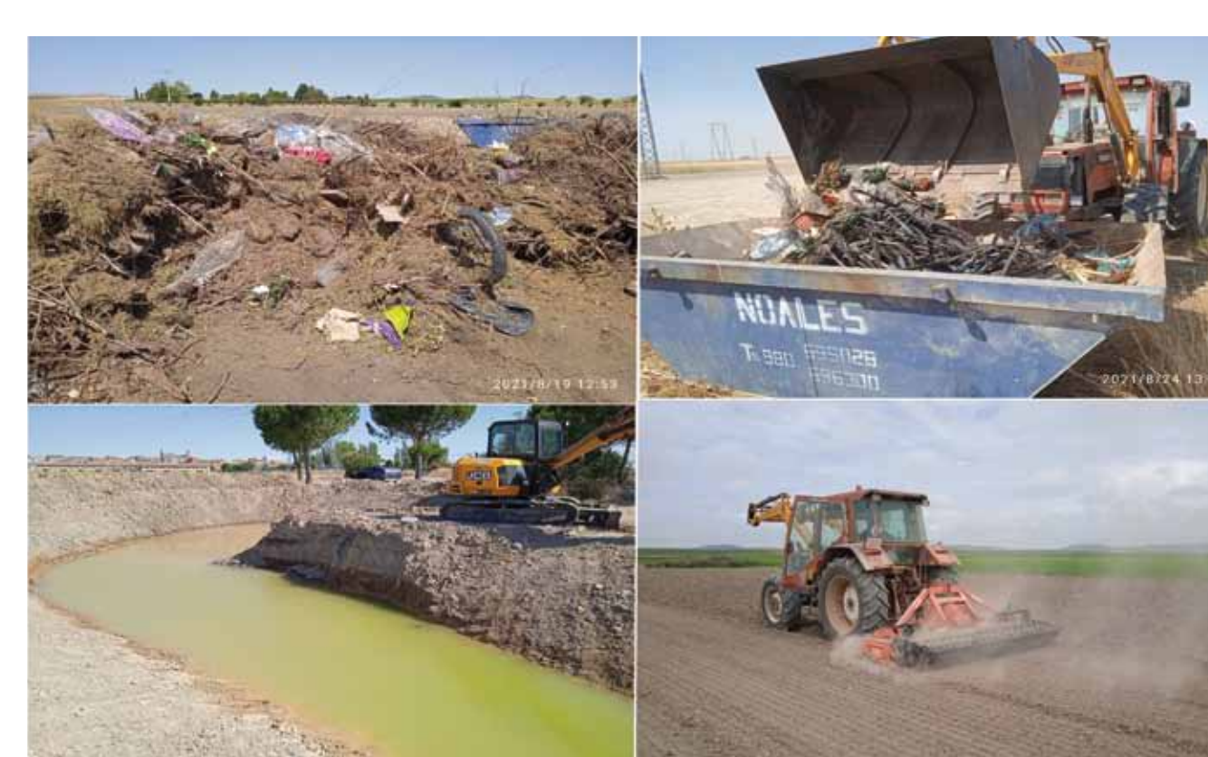
Figura 2. Algunas imágenes del proceso de retirada de residuos y movimiento de tierras para la restauración de la parcela
