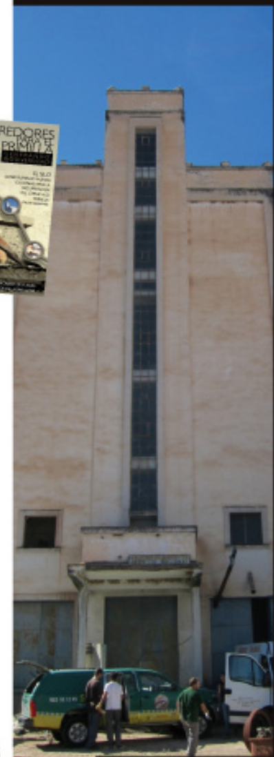
Actuación en silo
