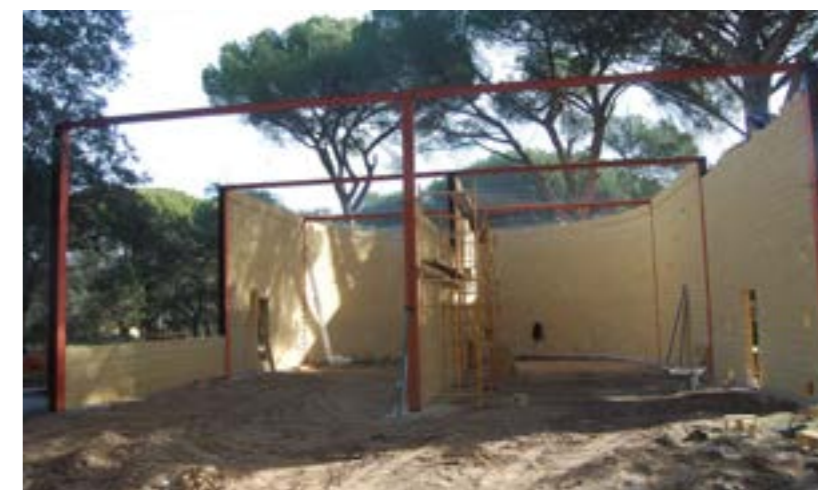
Voladero oval de GREFA en construcción, una instalación que será fundamental para la rehabilitación de muchas aves.
