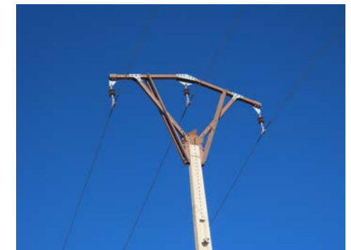
Prototipo de cruceta realizada con material aislante por el grupo I-DE
