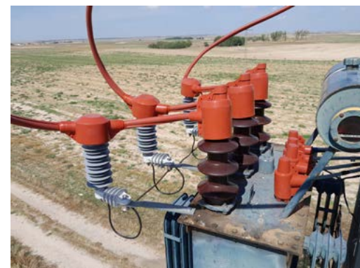
Primer plano de una adecuación de un tendido eléctrico
