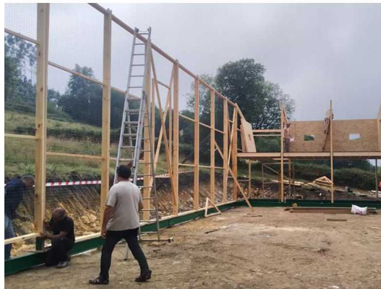
Construcción de la jaula
