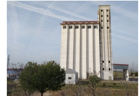
Panorámica del silo de Navalcarnero (Madrid).
