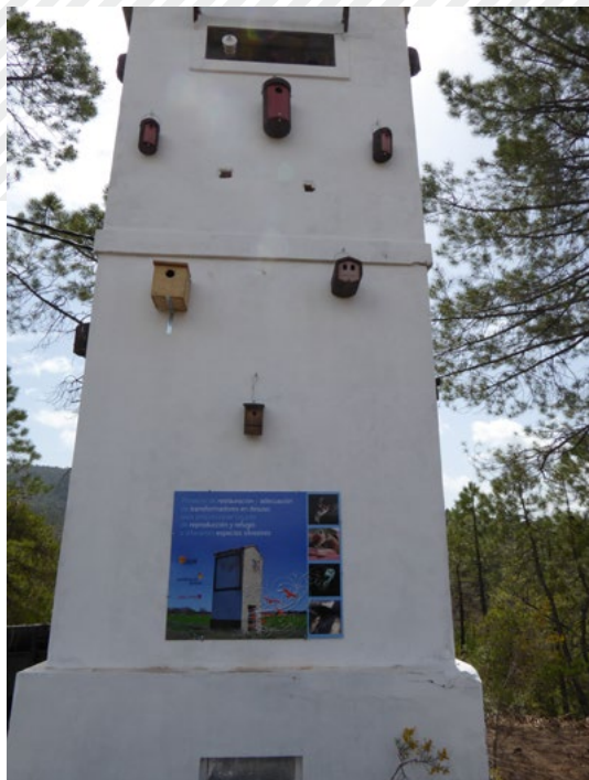
Caseta de transformador eléctrico rehabilitada como punto de biodiversidad, en Villalba de la Sierra (Cuenca).
