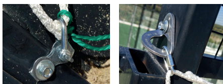
Uso de las chapas de anclaje, del fleje metálico perforado y de los mosquetones de tuerca. Los anclajes solo se fijan a los postes verticales
