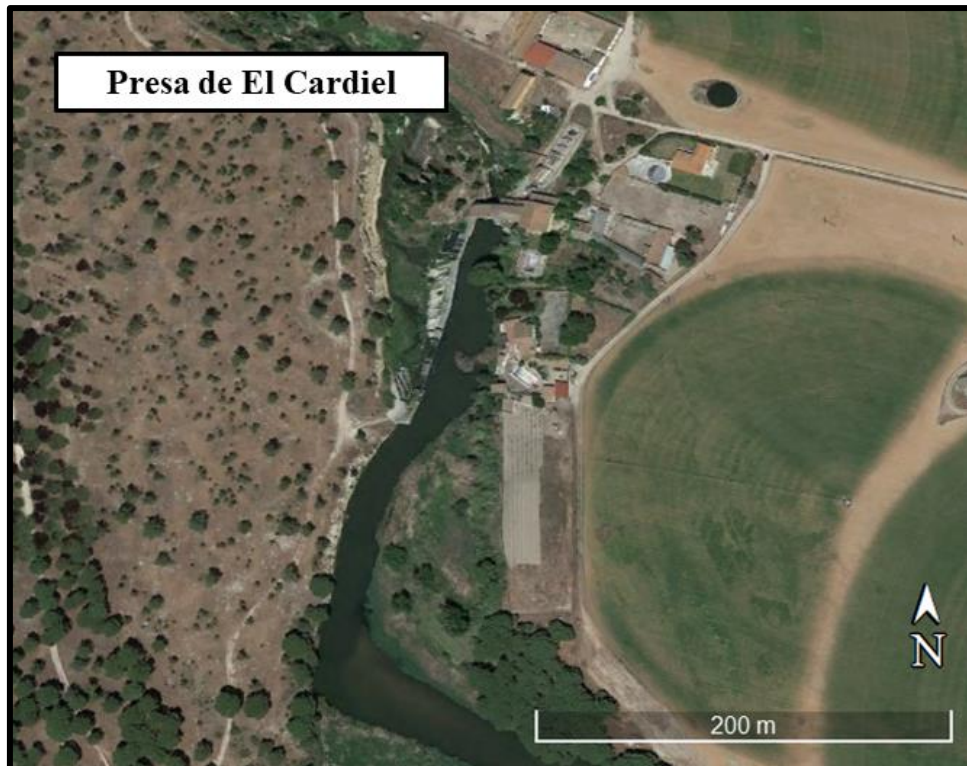
Figura 6. Imagen aérea de la azud en la presa de El Cardiel.
