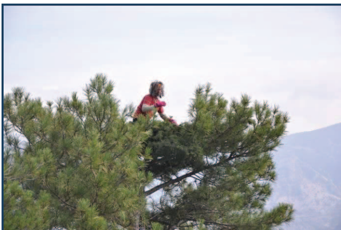
Fig. 21. Dernières retouches à l'une des plateformes construites cette année à Alinyà (photo: Aleix Millet)
