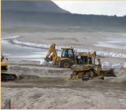
Maquinaria pesada traballando no humidal (26/01/2012).
