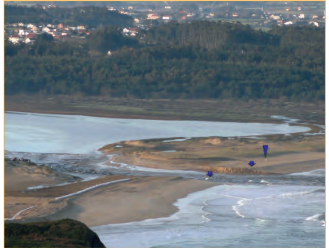
Rotura da barreira de area no mesmo punto onde os bulldózers traballaron incesantemente e baleirado da lagoa (30/01/2012).
